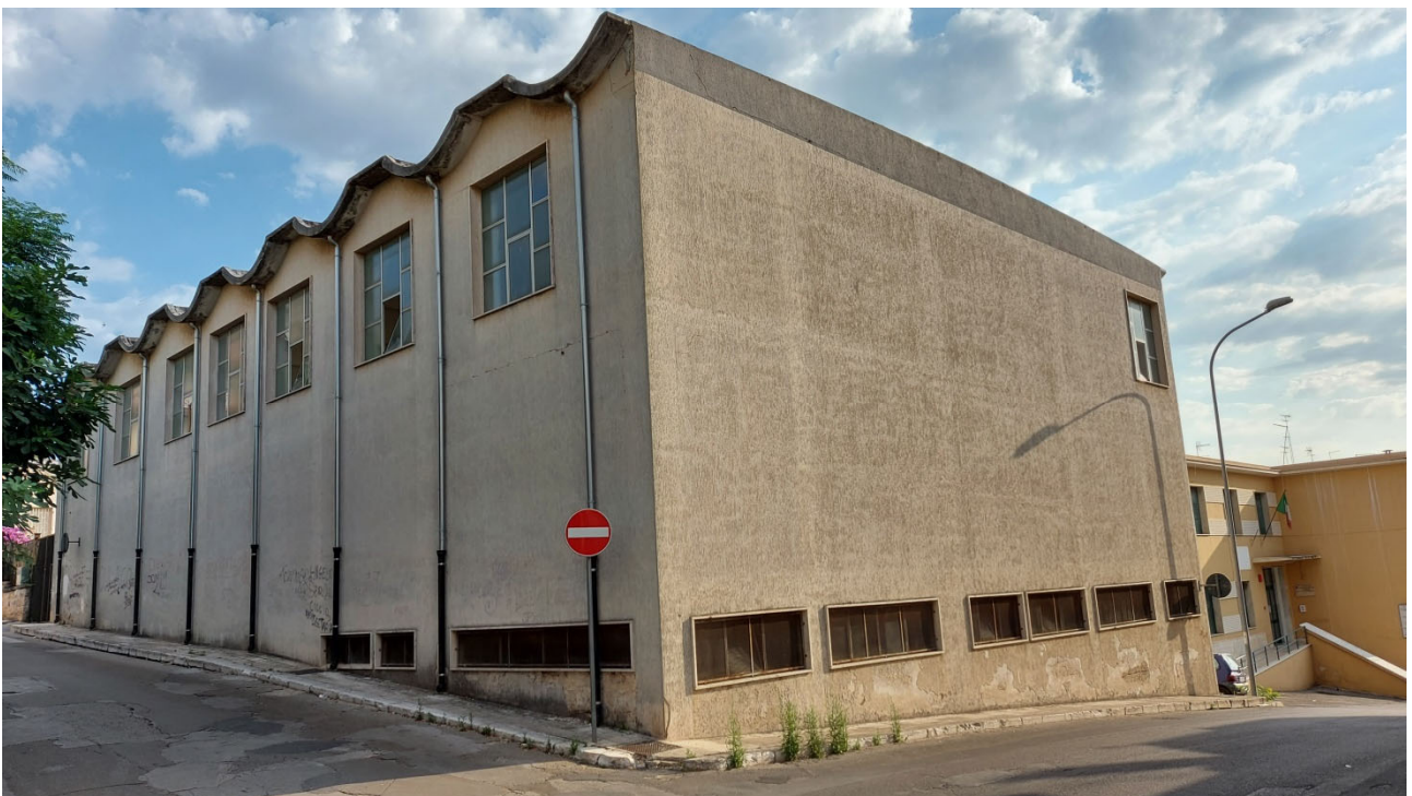
Foto 2 Lato Posteriore. Parete oggetto di rimozione e rifacimento degli intonaci. Via Sant' Antonio Abate-Via Giustino Fortunato
