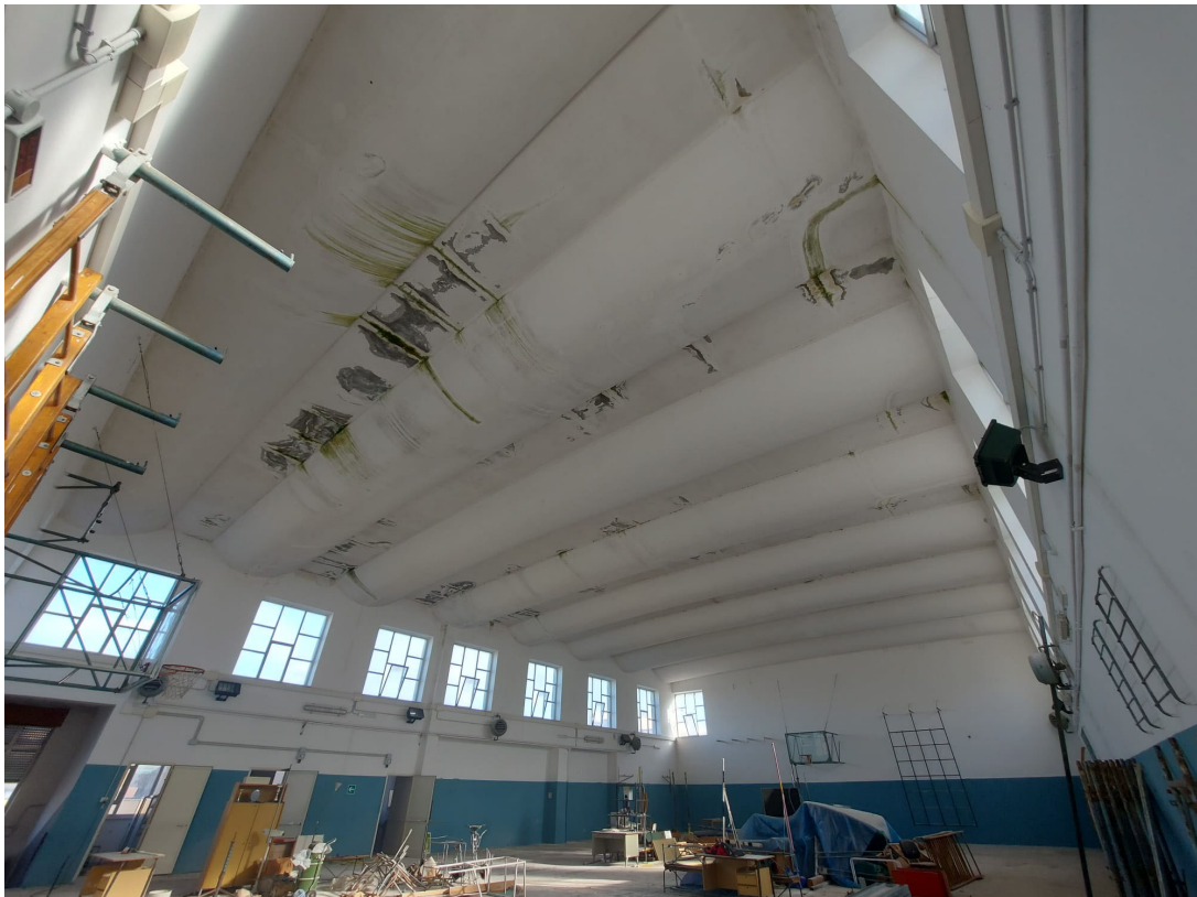
Foto 28 Stato di conservazione del solaio di copertura
