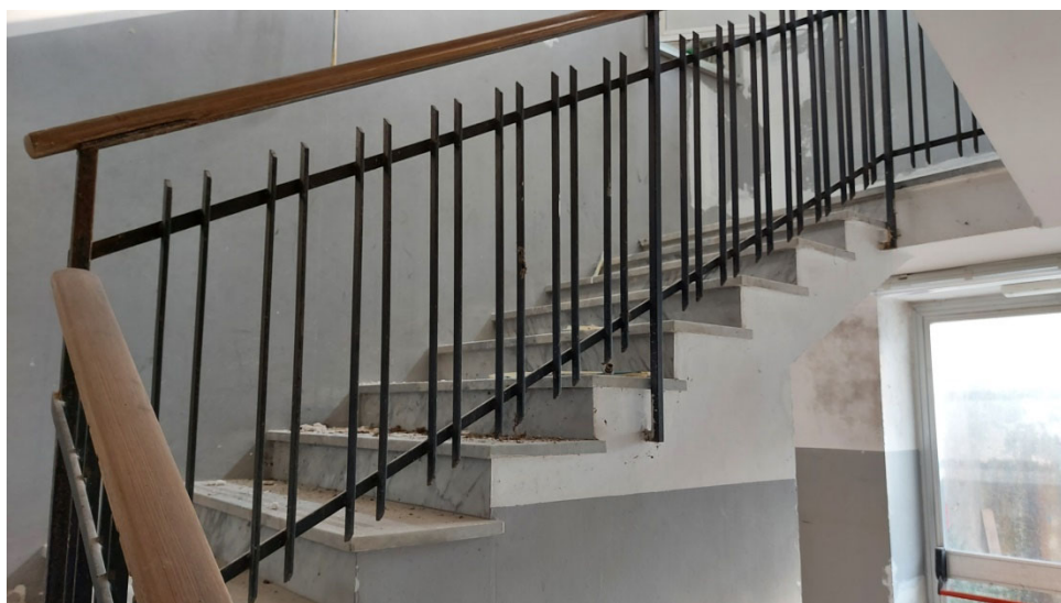
Foto 18 Recinzione interna da dipingere.
