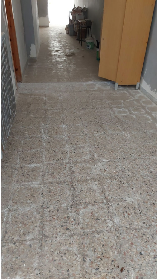
Foto 16 Pavimento da lucidare p.int.
