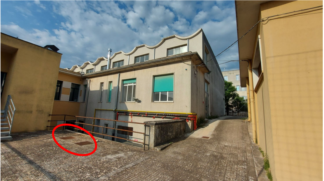
Foto 3 Prospetto cortile. Parete oggetto di rimozione e rifacimento degli intonaci. Evidenziate i chiusini delle cisterne della riserva idrica antincendio oggetto di intervento d'impermealizzazione
